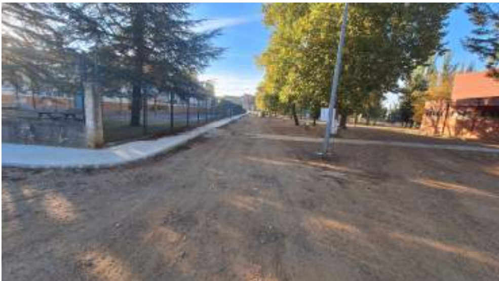
ACTUACION Nº 1. C/ VIVERO. CALZADA
