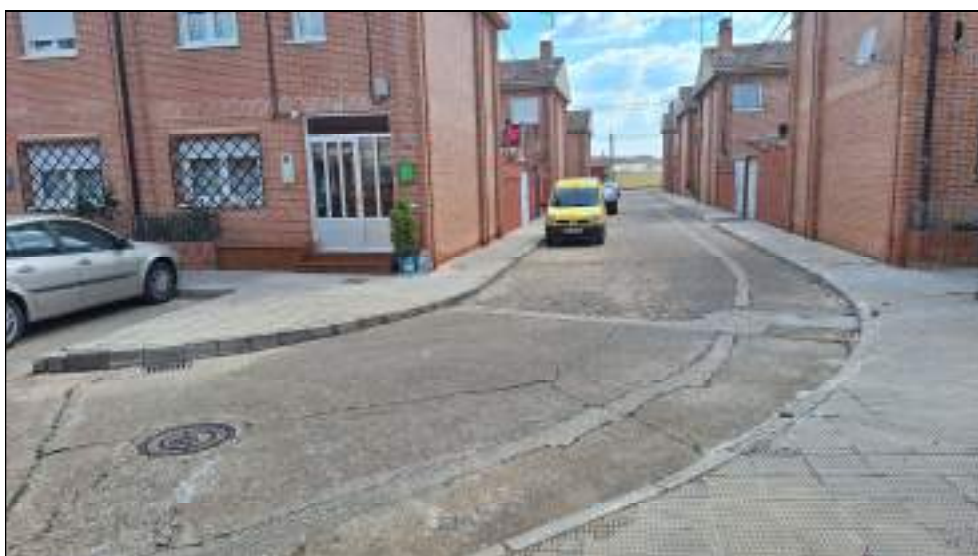
ACTUACION Nº 3. VISTA GENERAL AVDA VIRGEN ZORITA. 70 VVDAS
