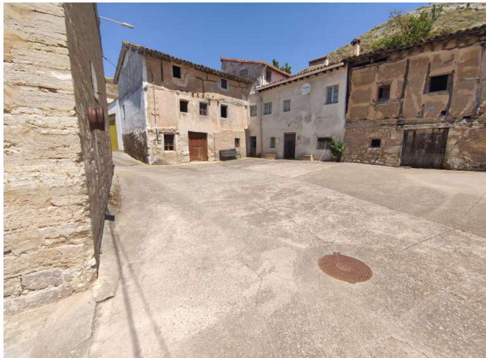
Foto 26: Plaza Valdeveza. Vista general.
