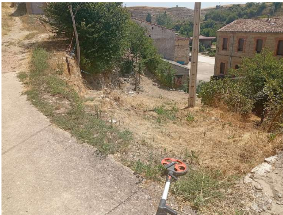
Foto 20: Vista desde C/ Calvario con poste de teléfonos en margen derecha
