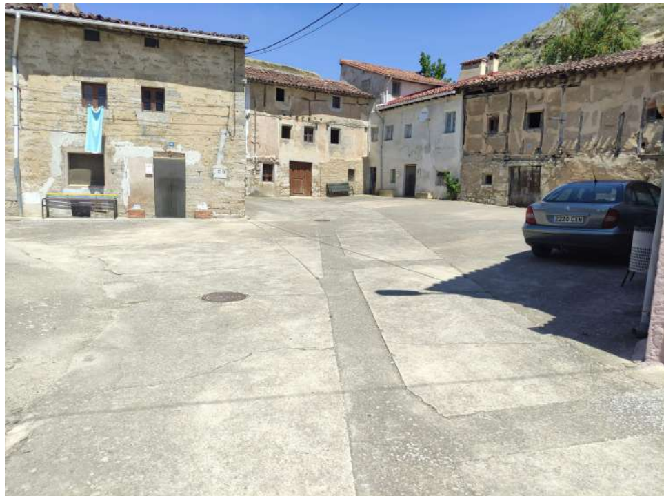
Foto 22: Plaza Valdeveza. Vista general.
