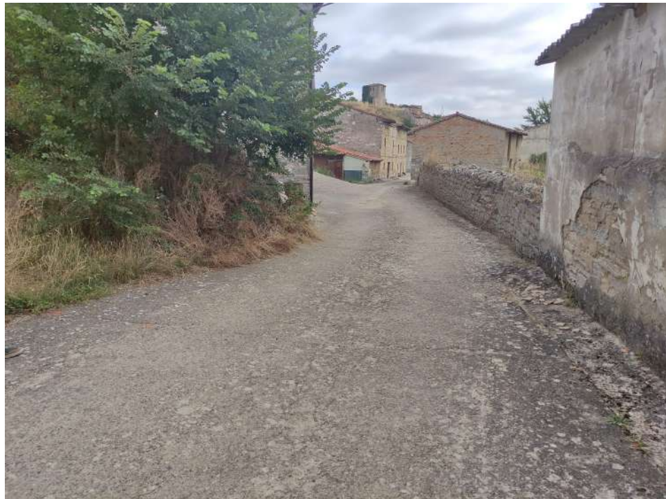
Foto 1: C/ Mayor. Zona Oeste
