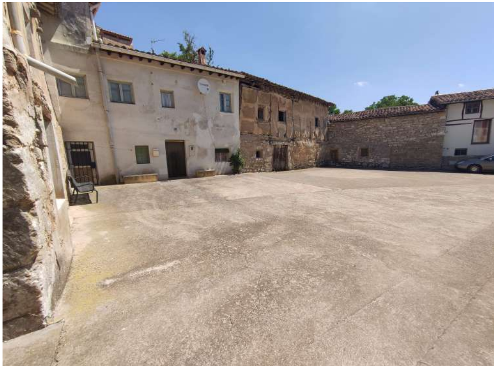
Foto 27: Plaza Valdeveza. Vista general.
