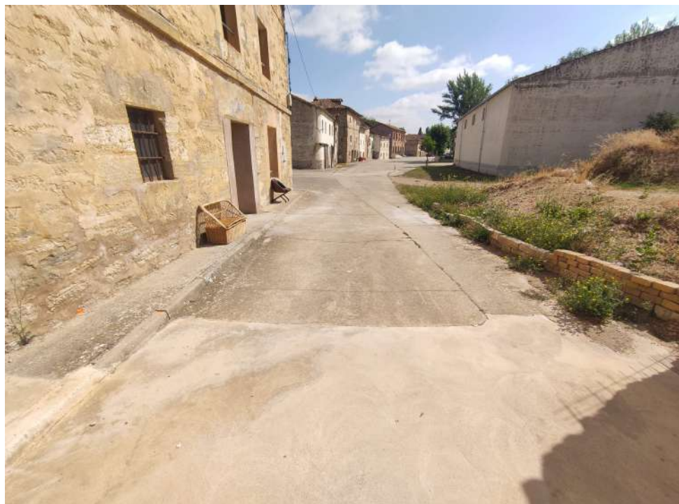
Foto 4: C/ Mayor. Zona Oeste
