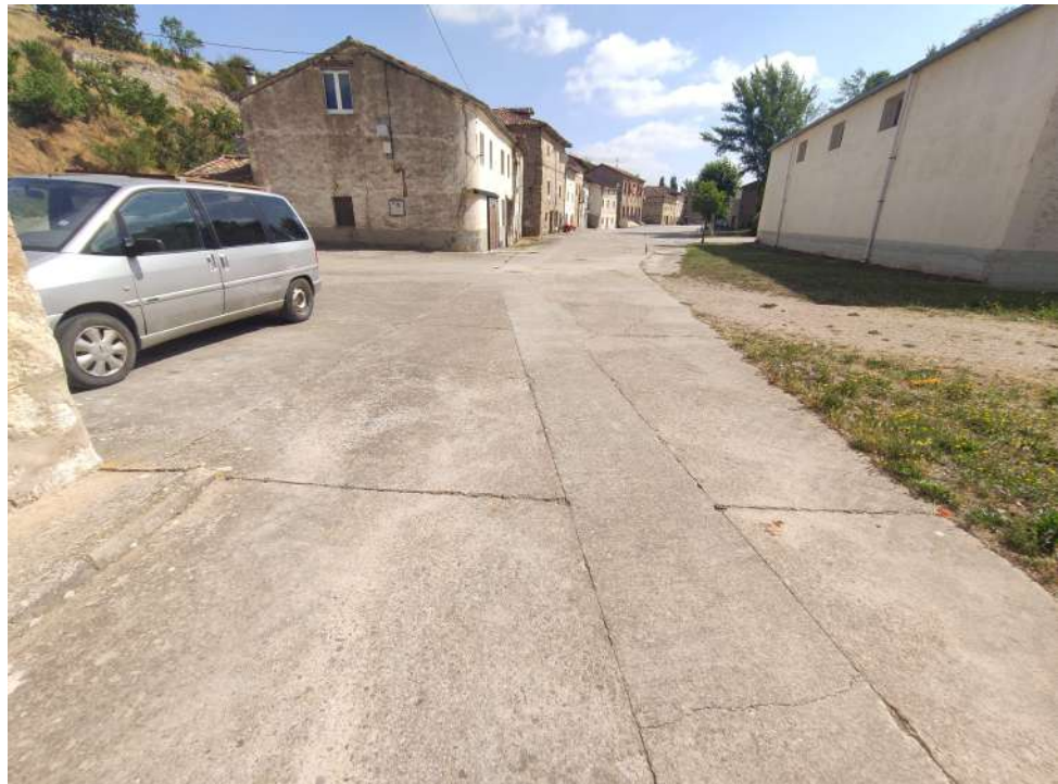
Foto 5: C/ Mayor. Vista general
