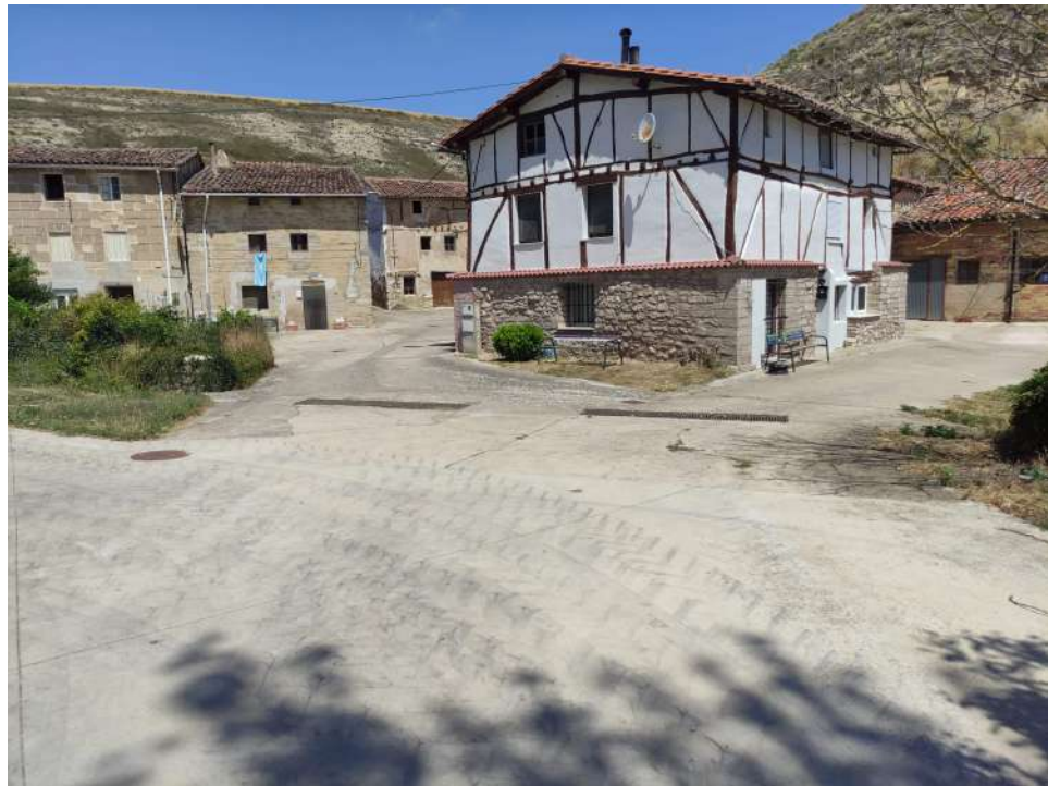
Foto 21: Plaza Valdeveza. Vista general.
