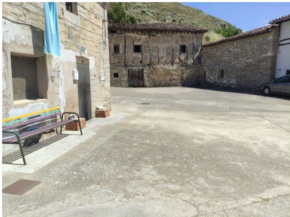
Foto 24: Plaza Valdeveza. Vista general.
