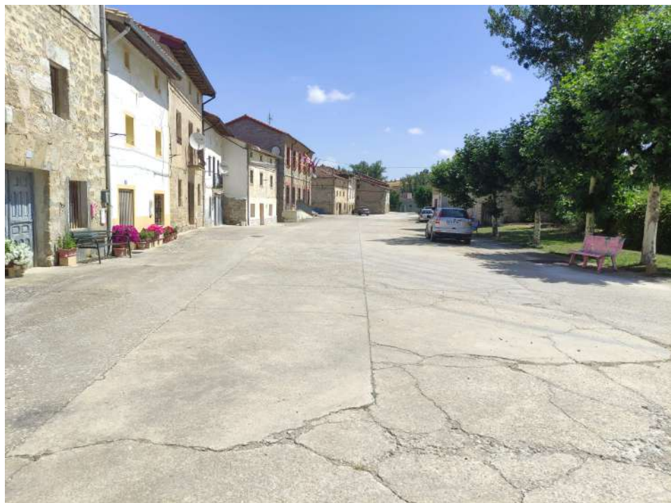
Foto 8: C/ Mayor. Tramo central y detalle del pavimento existente
