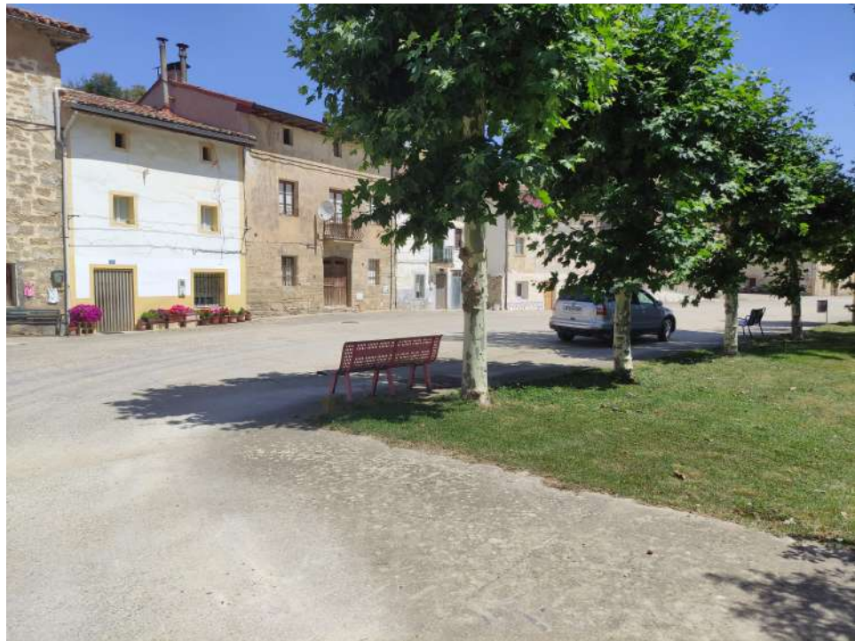
Foto 9: C/ Mayor. Vista general
