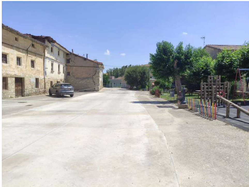
Foto 13: C/ Mayor. Vista zona ejecutada fases anteriores
