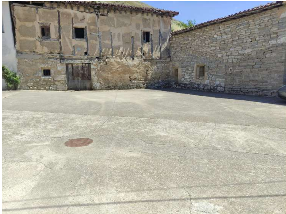
Foto 25: Plaza Valdeveza. Vista general.
