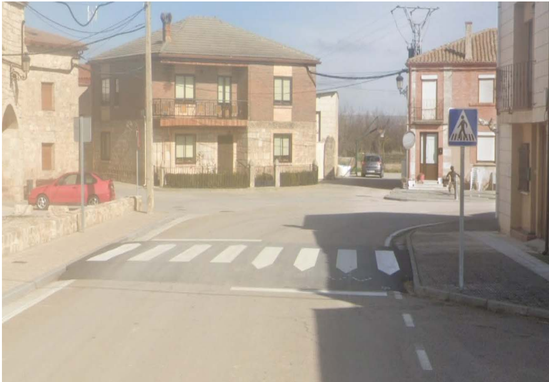
Fotografía I. Estado actual de travesía Castrillo de Murcia.
