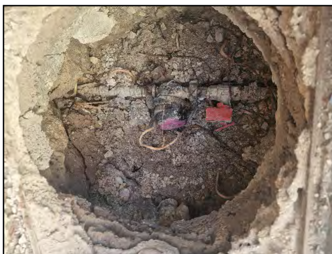
Instalar contador y sensor
