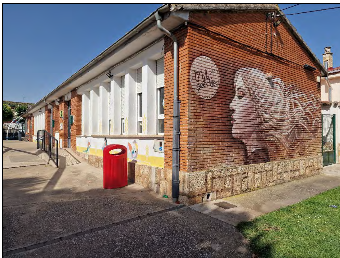
Peluquería lateral escuelas. Acometida particular.
