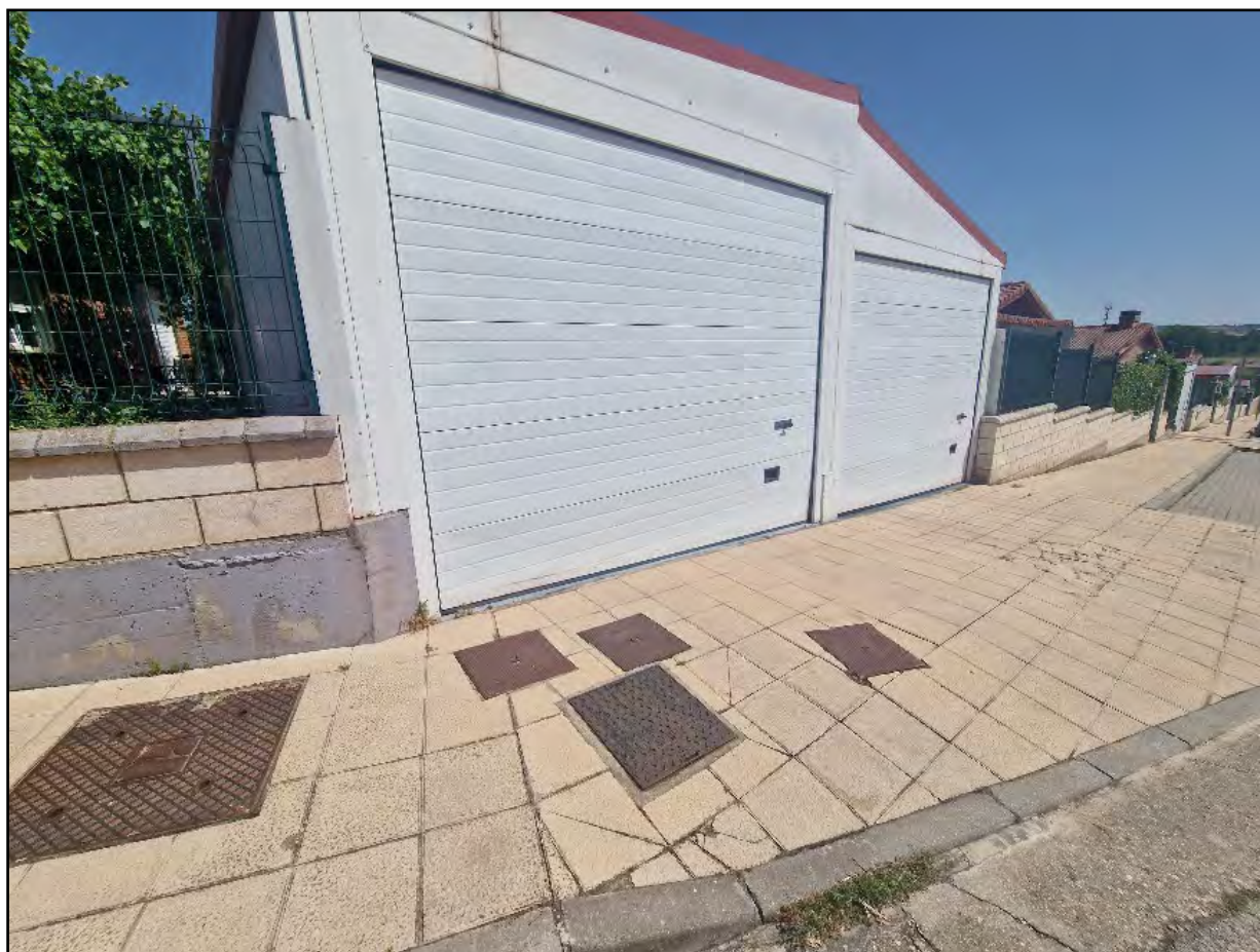
Acometida domiciliaria en acera. Acometida particular.
