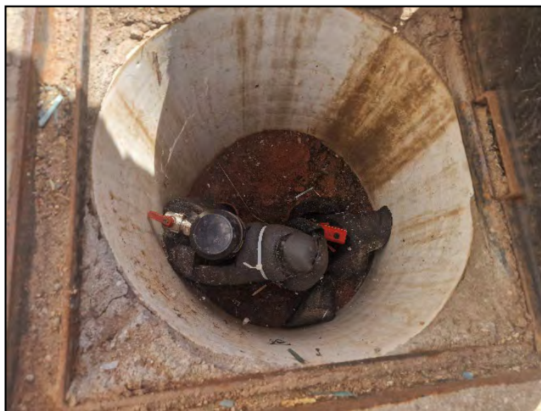
Instalar contador y sensor
