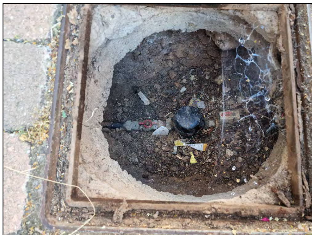
Acometida domiciliar en acera. Acometida particular.
