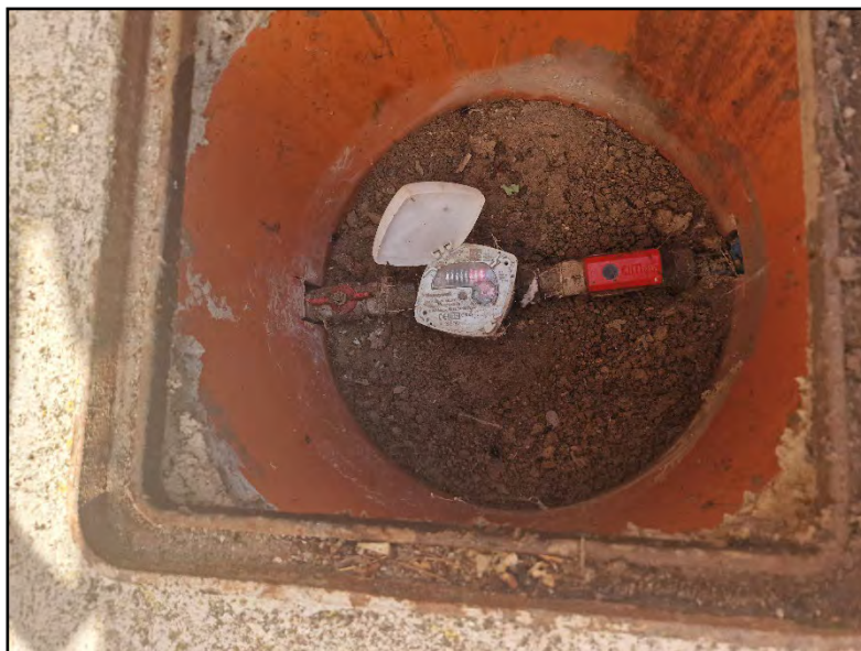
Instalar contador y sensor en arqueta existente
