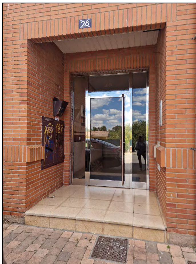
Contador en el interior del bloque de viviendas. Acometida particular.
