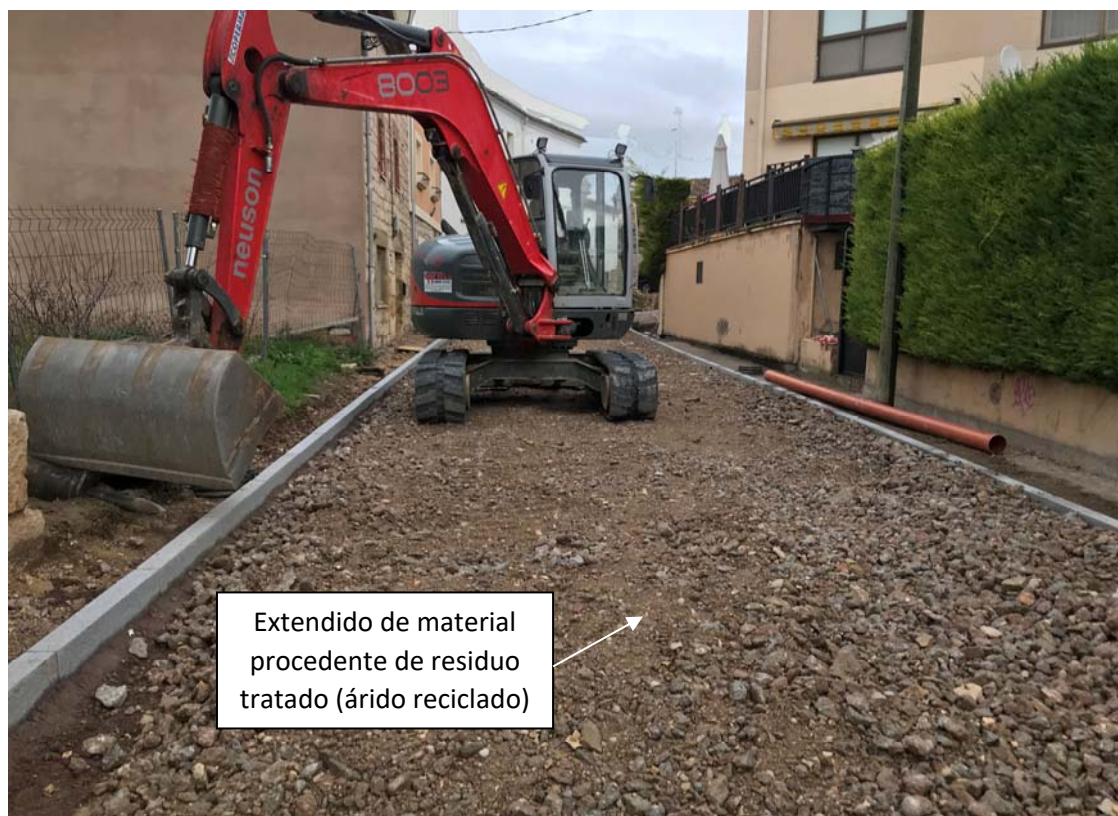
Fotografía reutilización de árido reciclado procedente de la demolición de firmes de la red viaria municipal.
