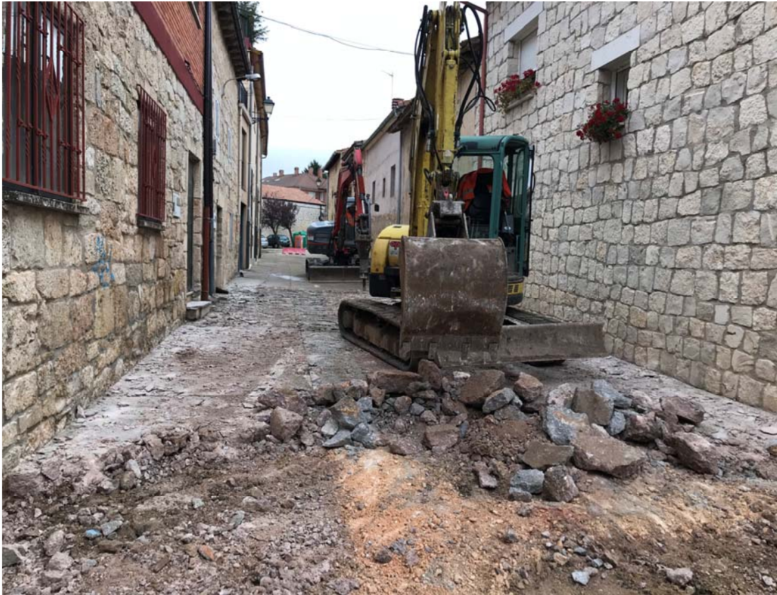
Fotografía de levantado de pavimento. El residuo generado se carga y transporta a lugar de acopio donde se procederá a la selección, tratamiento y valorización del residuo, (árido reciclado).
