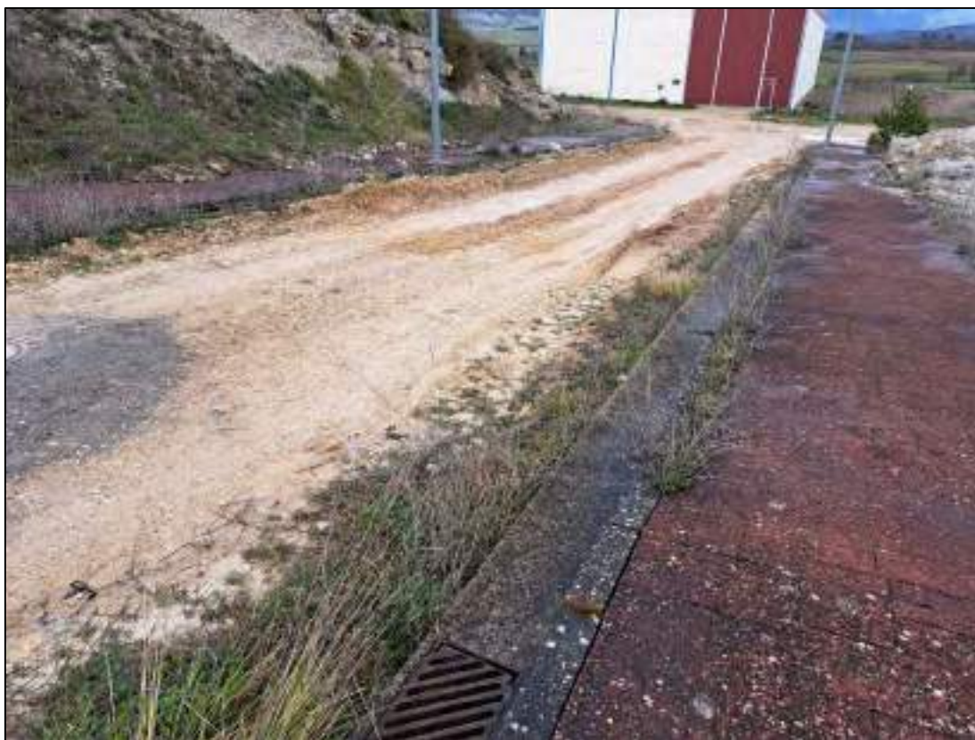
FOTO Nº9. Detalle de blandón en plataforma en C/ Las Paredillas.
