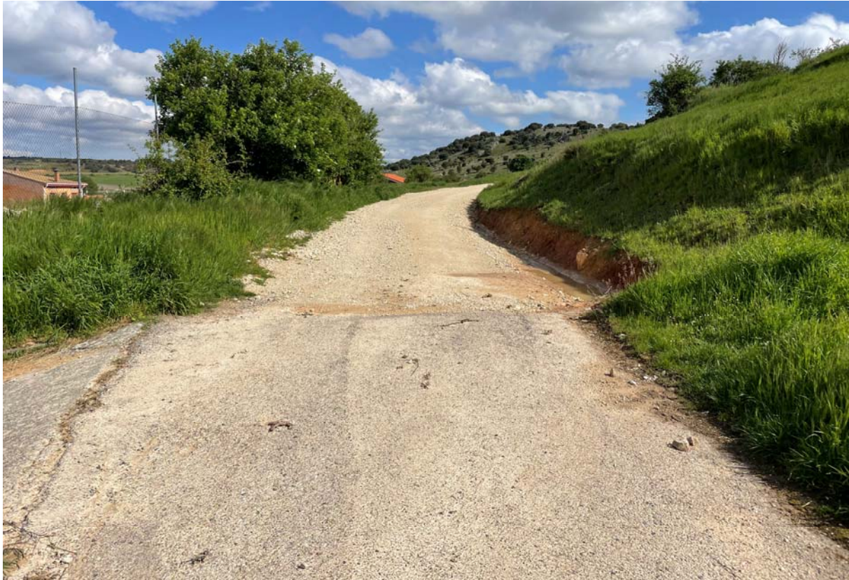
Fotografía III. Estado actual actuación.
