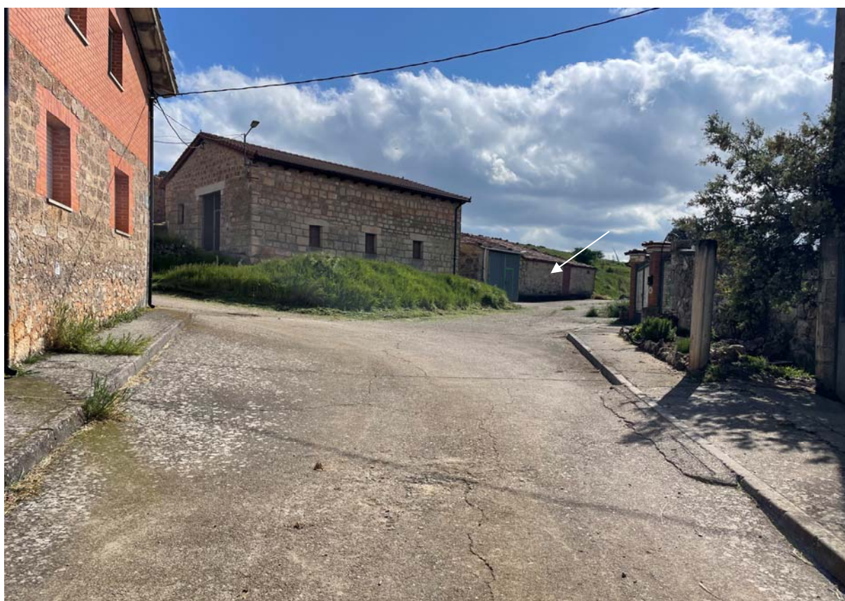
Fotografía I. Estado actual actuación.
