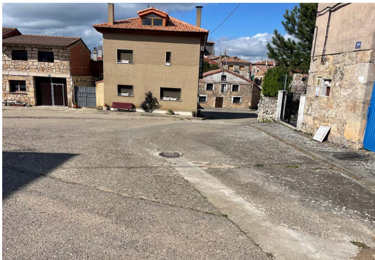
Fotografía II. Estado actual actuación.
