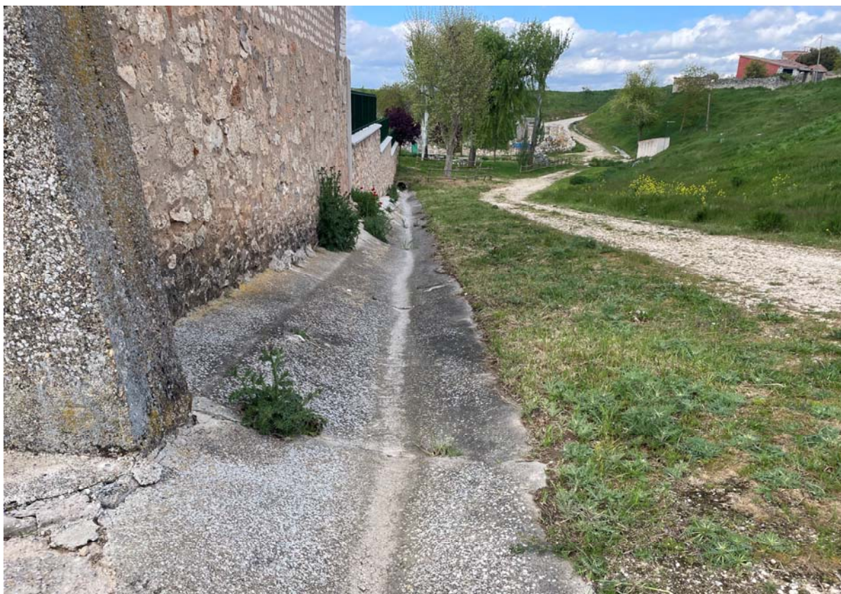
Fotografía V. Estado actual actuación.
