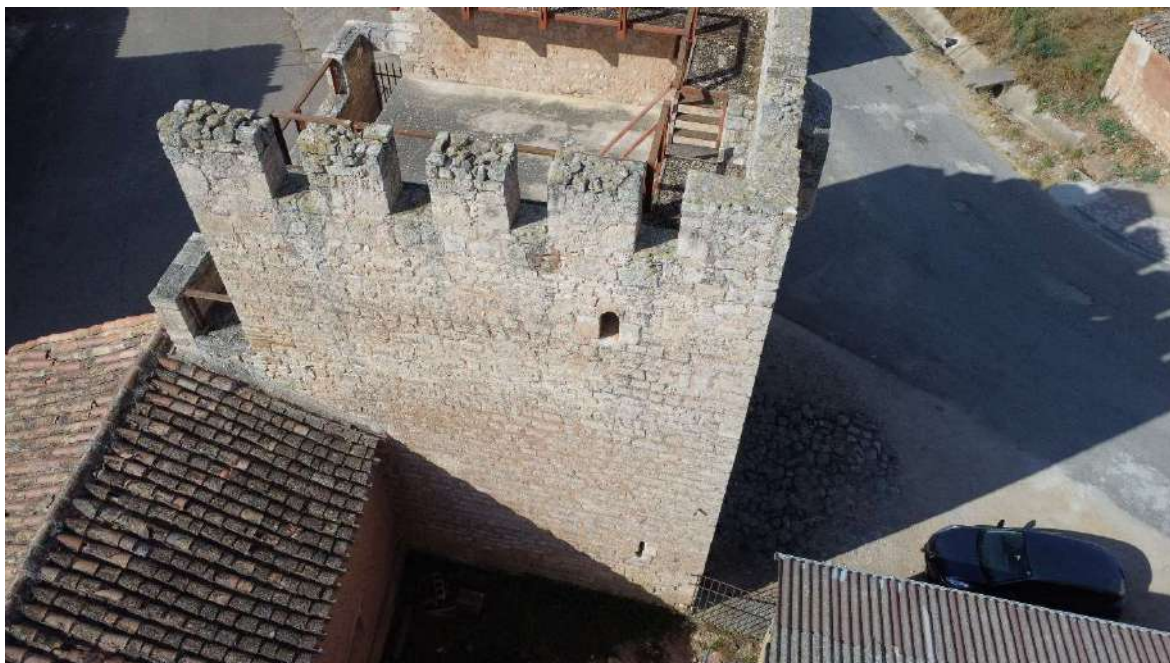
VISTA DE LA FACHADA SUDESTE
