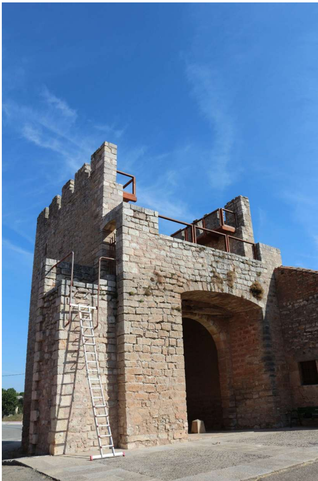
VISTA DE LA FACHADA SUDOESTE (INTERIOR DE LA MURALLA)
