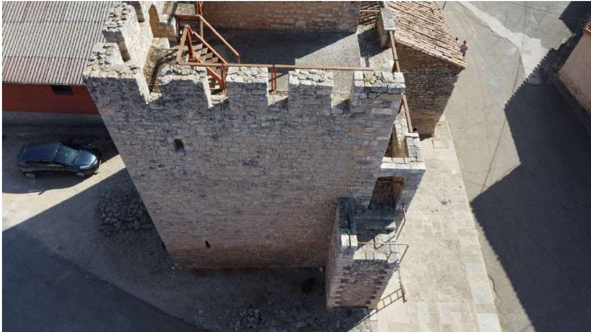
VISTA DE LA FACHADA NOROESTE
