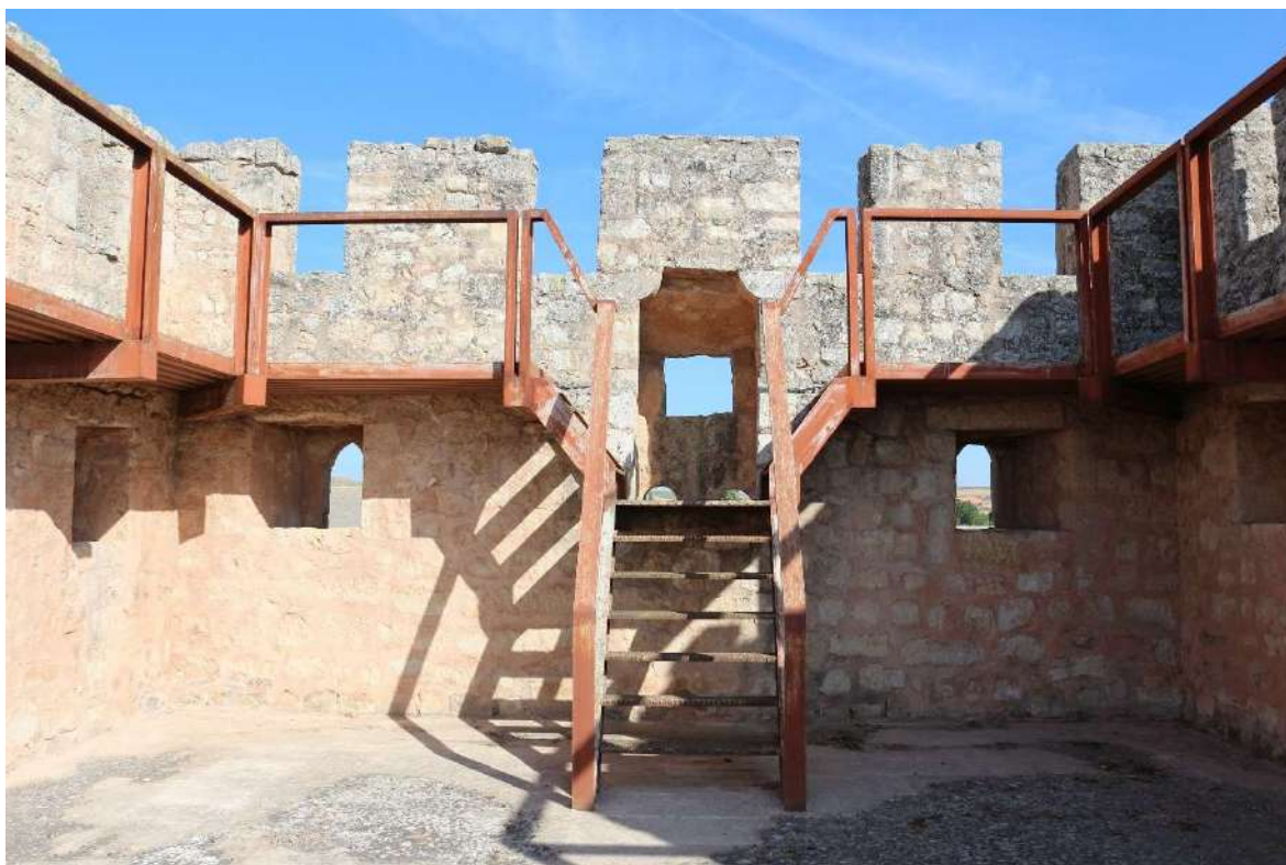
ESCALERA DE ACCESO AL PASO DE RONDA
