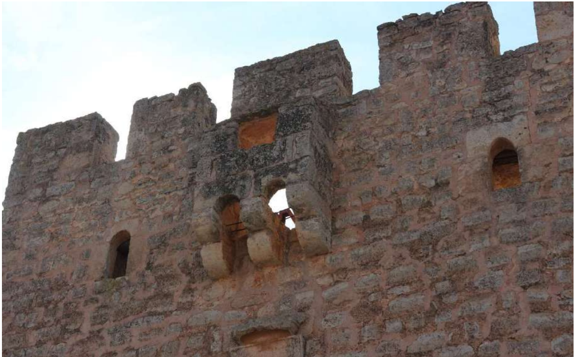
VISTA DEL REJUNTADO EN LA CARA NORDESTE
