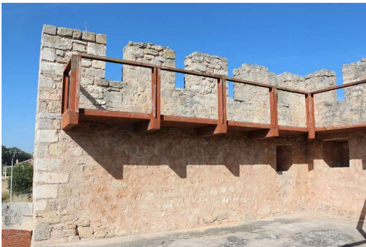
LATERAL DEL PASO DE RONDA
