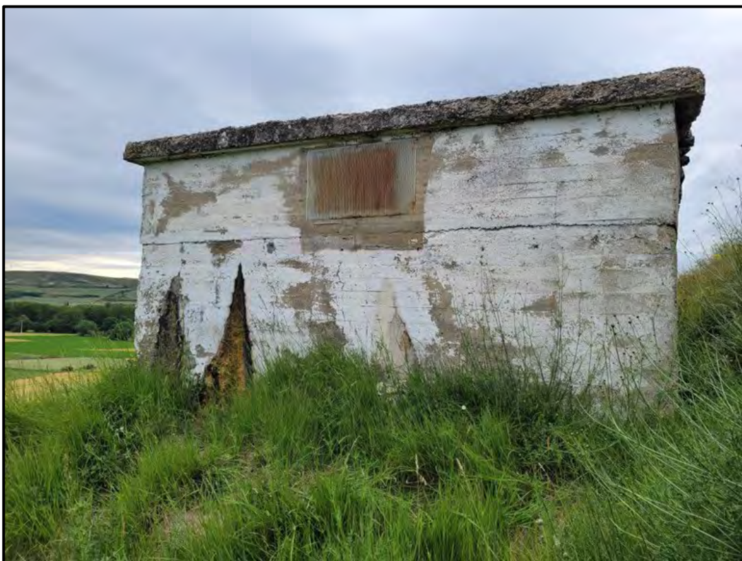
Depósito vista posterior, con grietas y fugas
