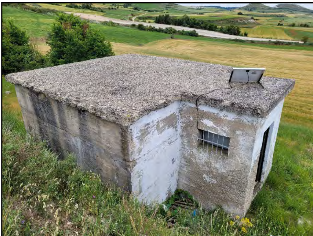
Depósito y caseta de llaves, vista de la cubierta, hormigón desintegrado
