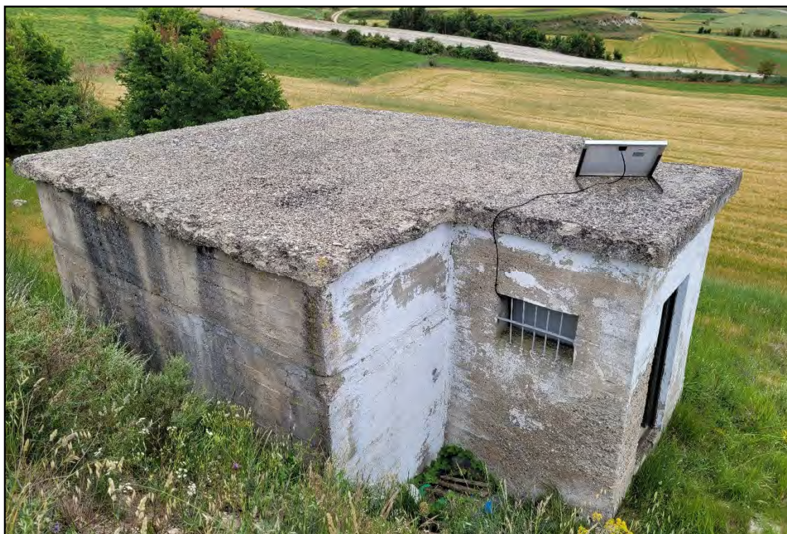
Vista de la cubierta en la que se aprecia el hormigón desintegrado
