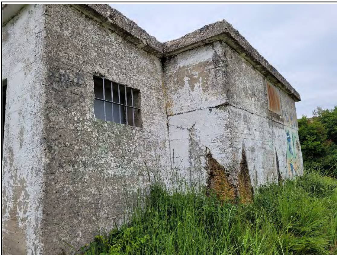
Vista del lateral derecho donde se aprecia el mal estado, con grietas y fugas
