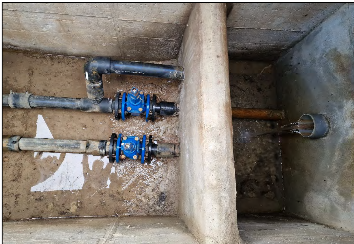
Vista del interior de la captación. Tuberías y válvulas existentes
