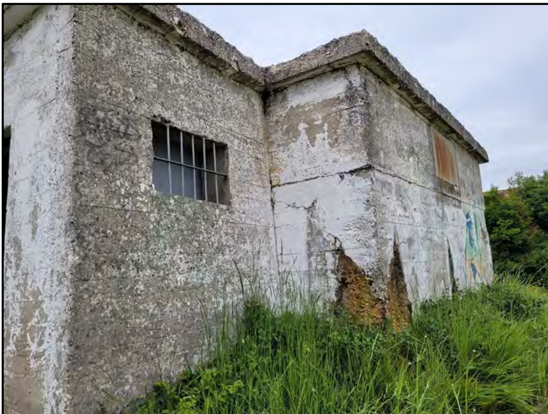
Depósito y caseta de llaves, vista lateral derecho, con grietas y fugas.
