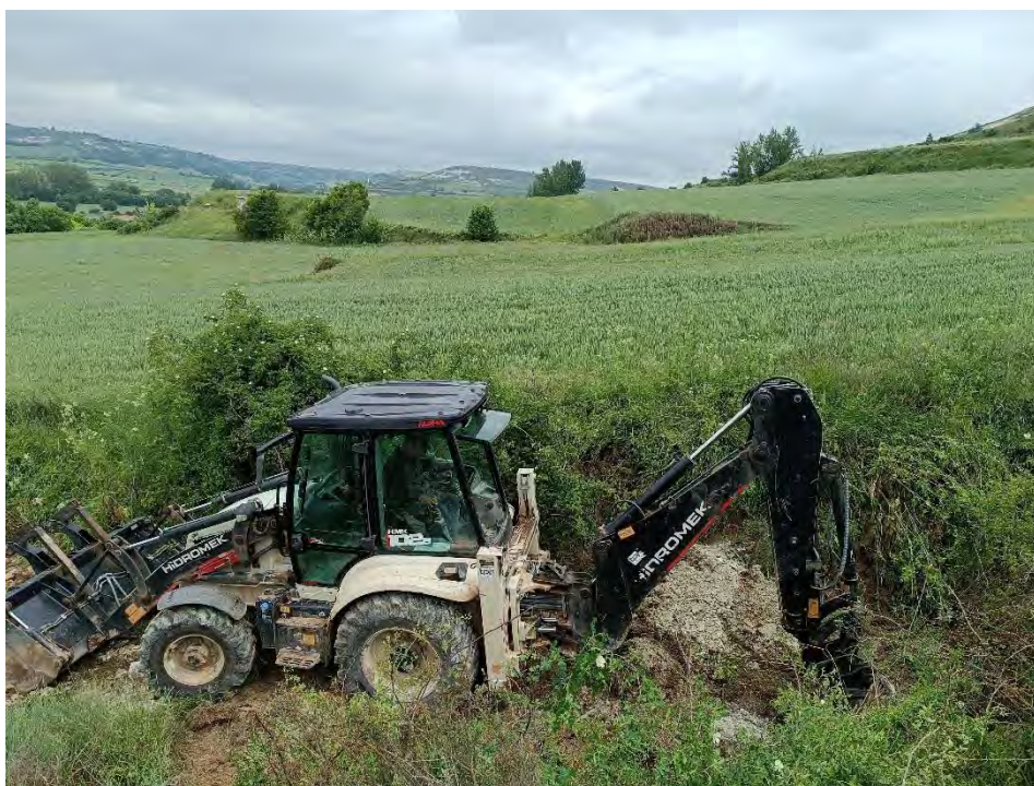
Retroexcavadora llevando a cabo la calicata.
