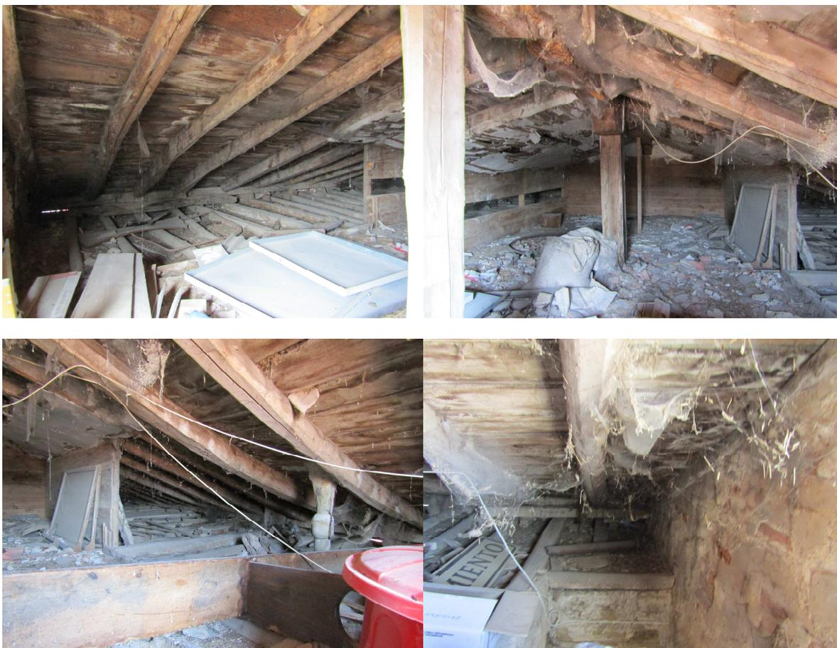
El actual edificio necesita mejorar la cubierta por comienzo de agotamiento del entramado de madera existente y se plantea sustituirla por completo, con materiales similares a los existentes. Se ve clara presencia de pudrición en vigas, presencia de Xilofagos y amplias flechas en cabios.
