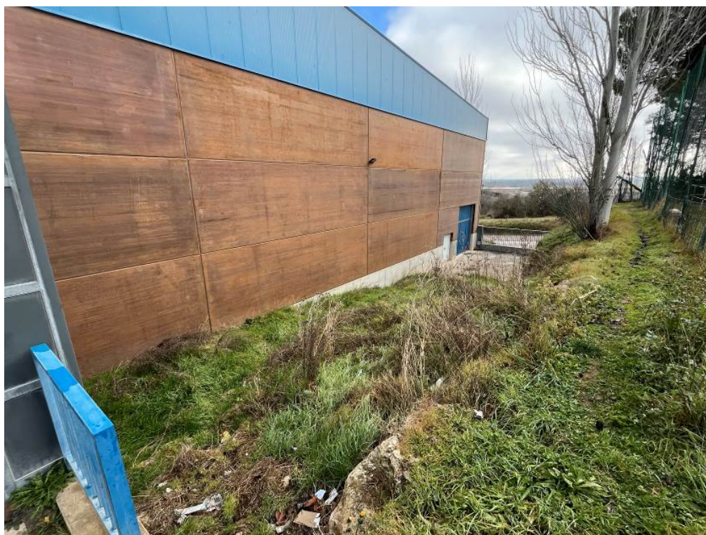
FOTOGRAFÍAS ESTADO ACTUAL _ ESPACIO DEL CALLEJÓN / ZONA DE CONSTRUCCIÓN DEL GIMNASIO
