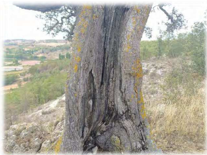
Foto. 24.4. Estado exterior del tronco principal
