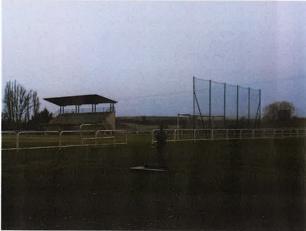
Imagen 6. Red de protección del campo de fútbol a ampliar.
