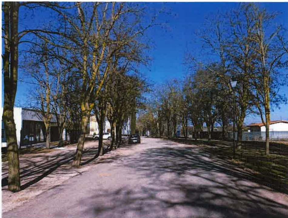
Imagen 4. Zona del aparcamiento de las piscinas sin pavimentar.
