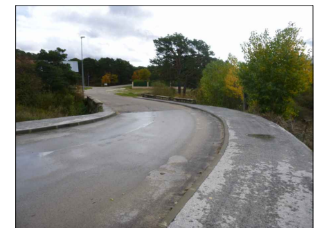
PUENTE CAMINO DE QUINTANAR DE LA SIERRA A REGUMIEL
