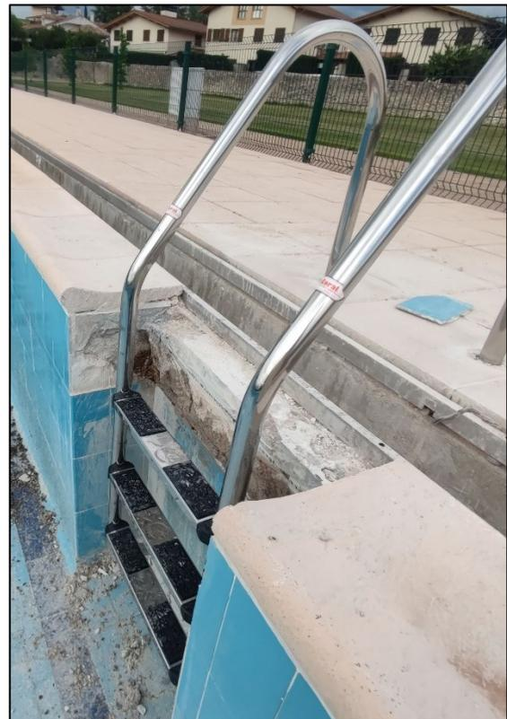
Fotos nº 3 y 4.- Fotos procedentes de las obras de arreglo de las escaleras del año 2023, donde se puede comprobar el mal diseño origen ejecutado para el rebosadero perimetral, apreciándose la discontinuidad en el hormigón, lo que produce fugas a través de las juntas de las distintas piezas que lo forman.
