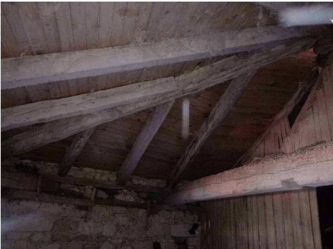
11 y 12.- La penetración de agua es más frecuente en las partes más bajas, junos al apoyo en las fábricas y en los aleros.
