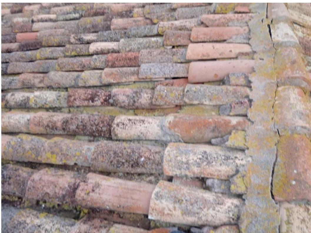
4.- Detalle de una zona de la nave principal con el desplazamiento en la cumbre que se relleno con mortero de cemento.
