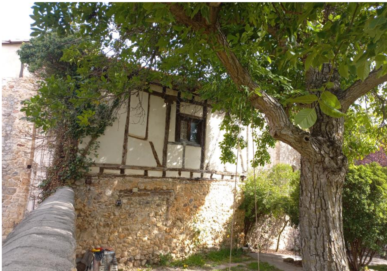
Vista lateral de la casilla
