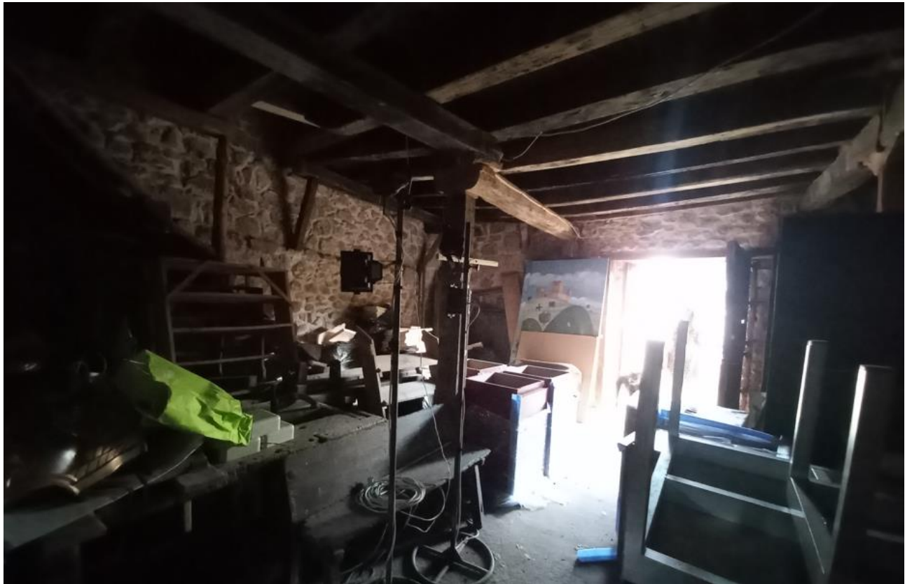
Interior de la planta baja
