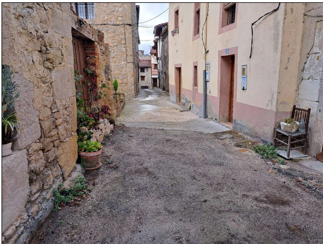
FOTO N°4. Final de tramo de calle Hospital. Encuentro con firme renovado.
