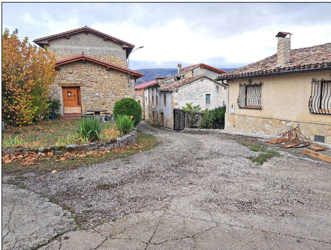
FOTO N°1. Calle Hospital. Cruce con calle Pino. Inicio de tramo.
