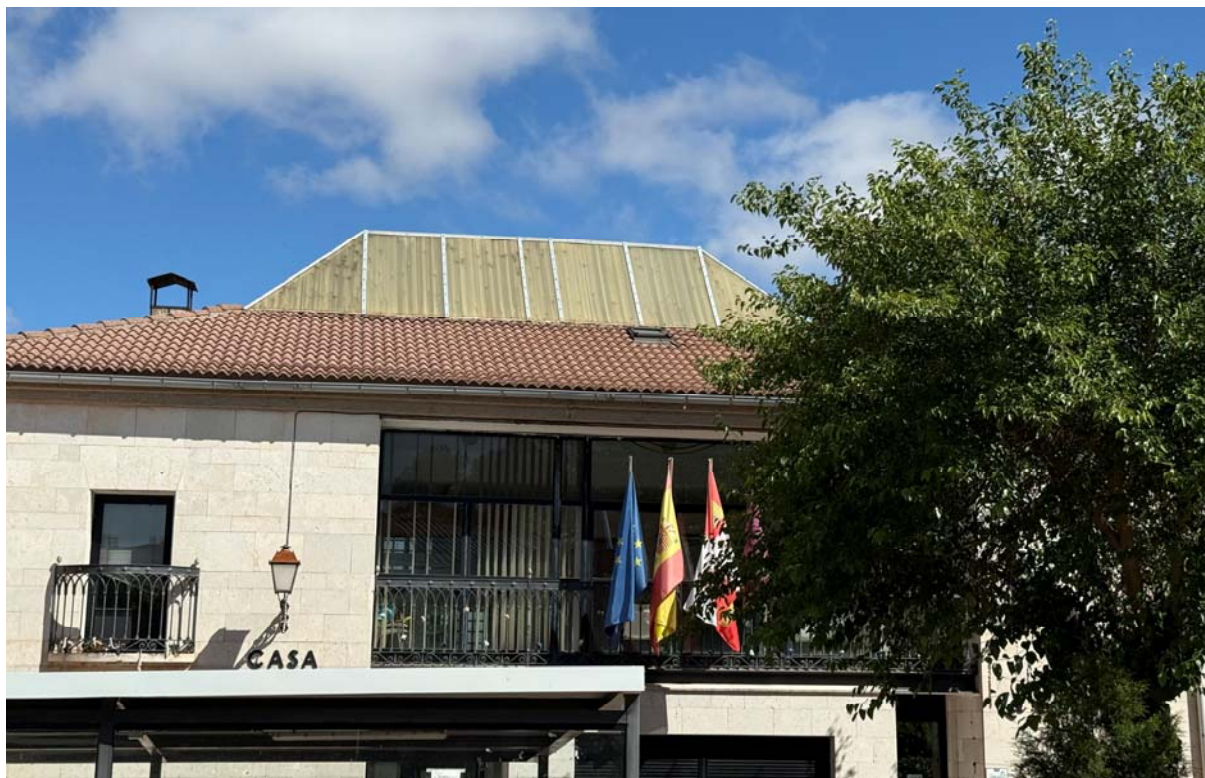
Fotografía I, estado actual zona actuación. (Cubierta vista de fachada principal).
