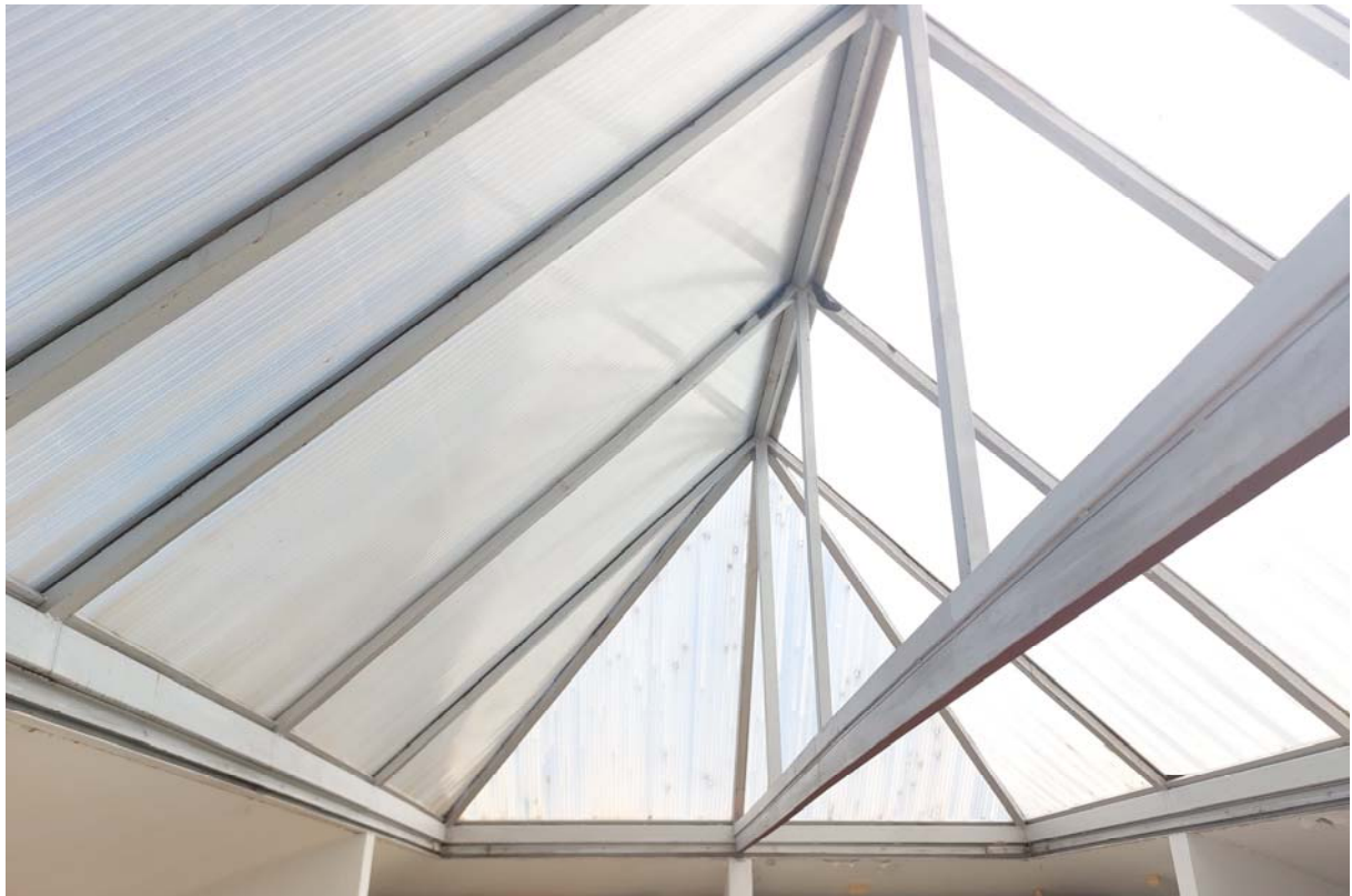
Fotografía II, estado actual zona actuación. (Estructura base soporte actual cumbrera de metacrilato).
