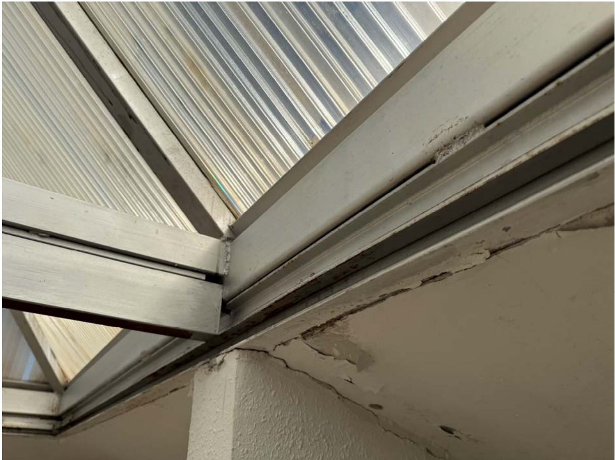
Fotografía II, estado actual zona actuación. (Estructura base soporte actual cumbrera de metacrilato).
