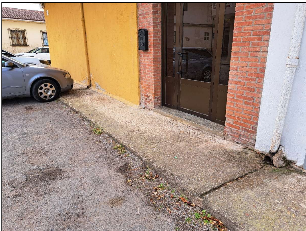
FOTO Nº3. Detalle de acera y bajante de cubierta en portal nº1.
