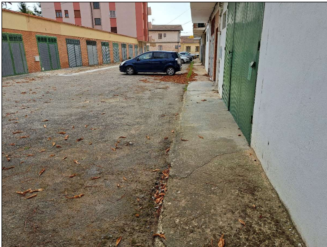
FOTO N°5. Detalle de acera en bloque nº5.
