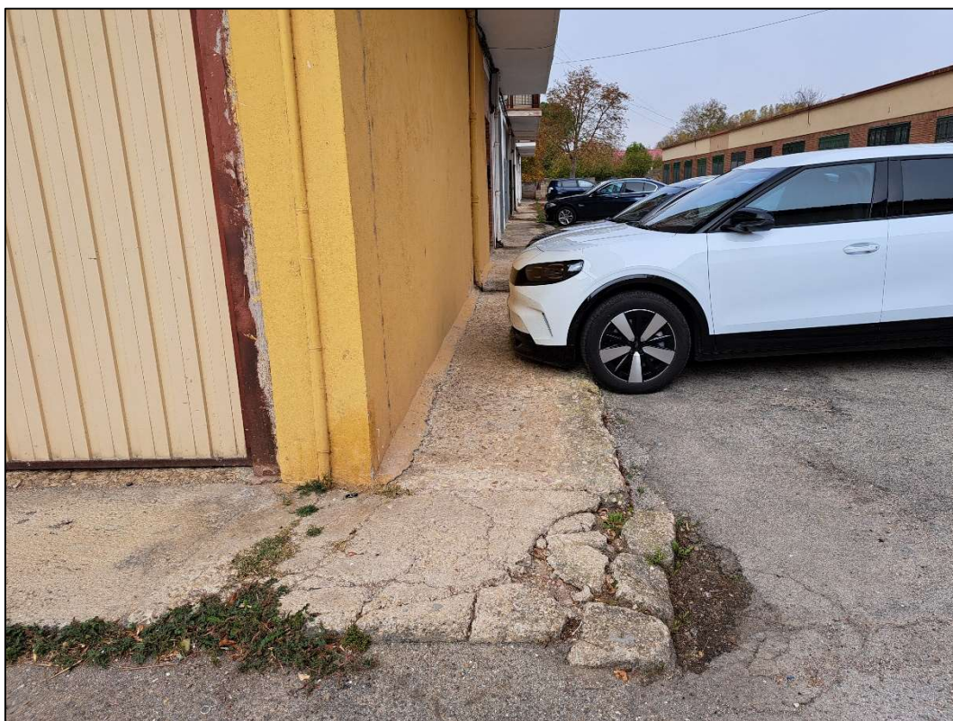
FOTO N°2. Detalle de plataforma de acera en margen izquierda. Inicio de tramo.
