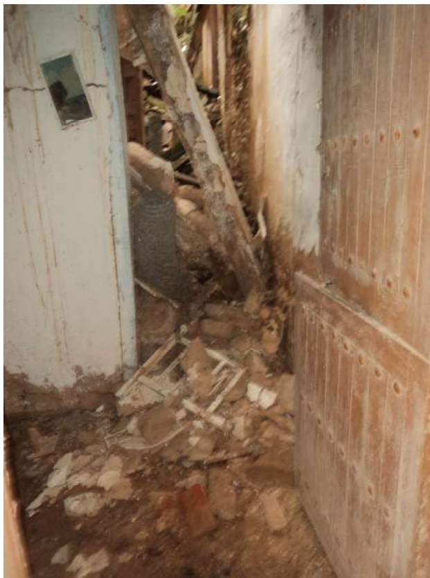
Fachada entrada a vivienda nº 4 y su interior en planta baja derruido.
