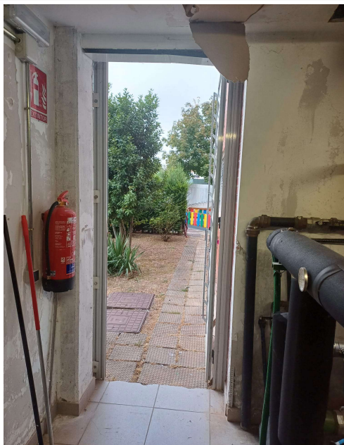
Vista general de la entrada
