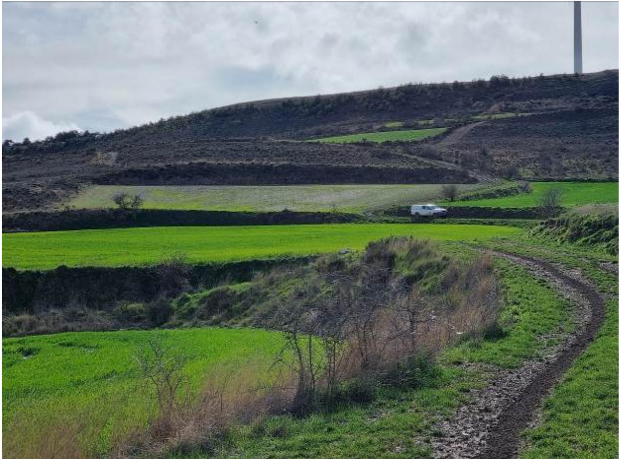
Fotografía 8, Detalles del estado del firme, la gran pendiente y de la plataforma camino, regueros, baches, charcos y roderas.
