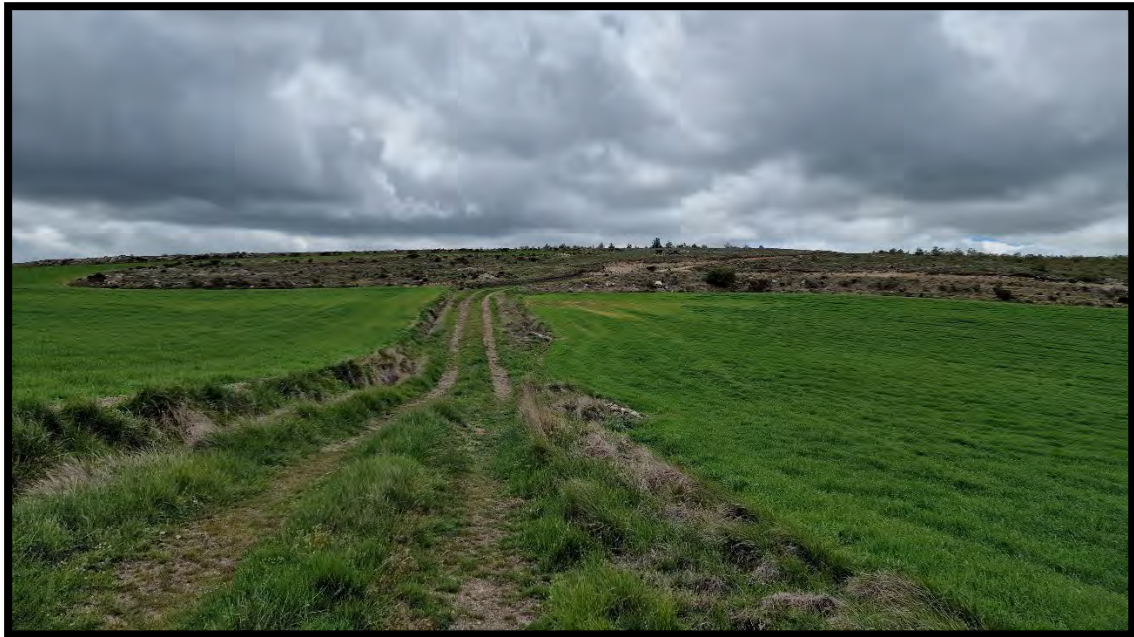
Zona cubierta de vegetación tanto en cunetas como en el camino
