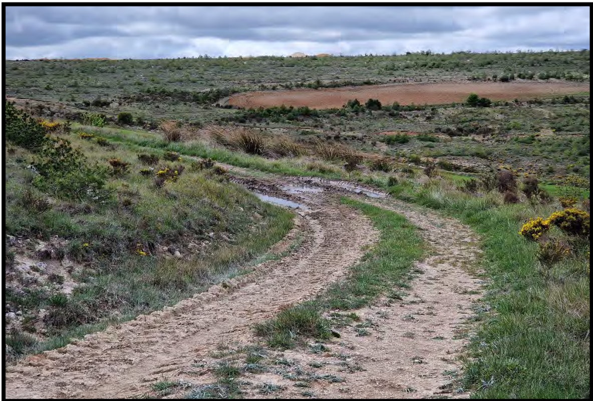
Curva en pendiente en la que el agua se queda en el camino
